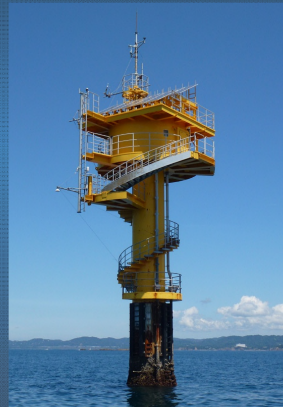
田辺中島高潮観測塔 海面から避雷針までの高さ23m
