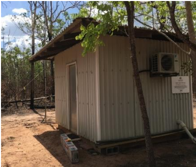
<写真 1: KDU の建物>
