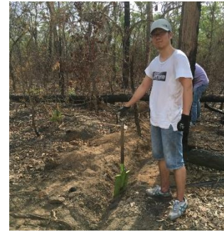
<写真 3: ケーブルを埋めるための溝を掘る筆者>
